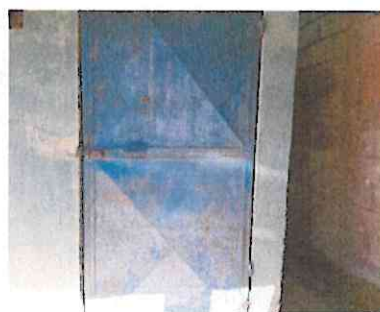
Foto 6: Se le dara mantenimiento con retoque de pintura.
