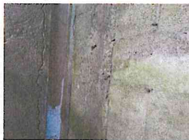
Foto 4: Se colocaran tubos en los drenajes.
