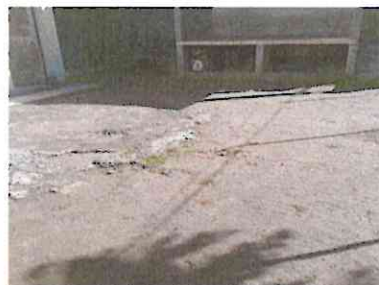
Foto 2: Reparacion de losa en el patio.
