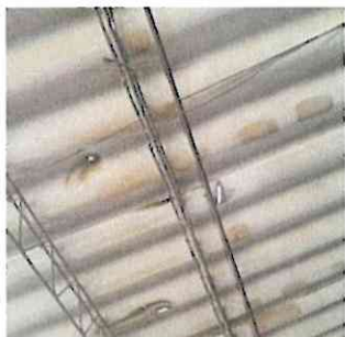
Foto1: Se cambiara las laminas del salón de clase
